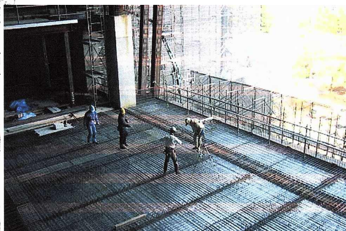
測定アンテナ設置風景
